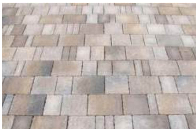
Pavimentazione in betonelle autobloccanti
