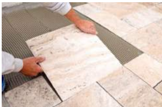
Pavimentazione in gres per marciapiedi
